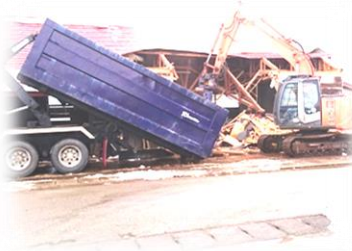
重機で解体される農舎
